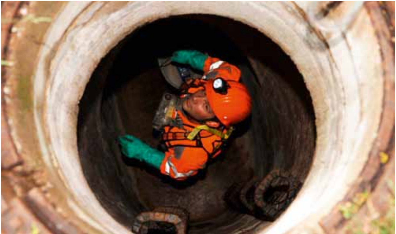
Kanalarbeiter im Einsatz
