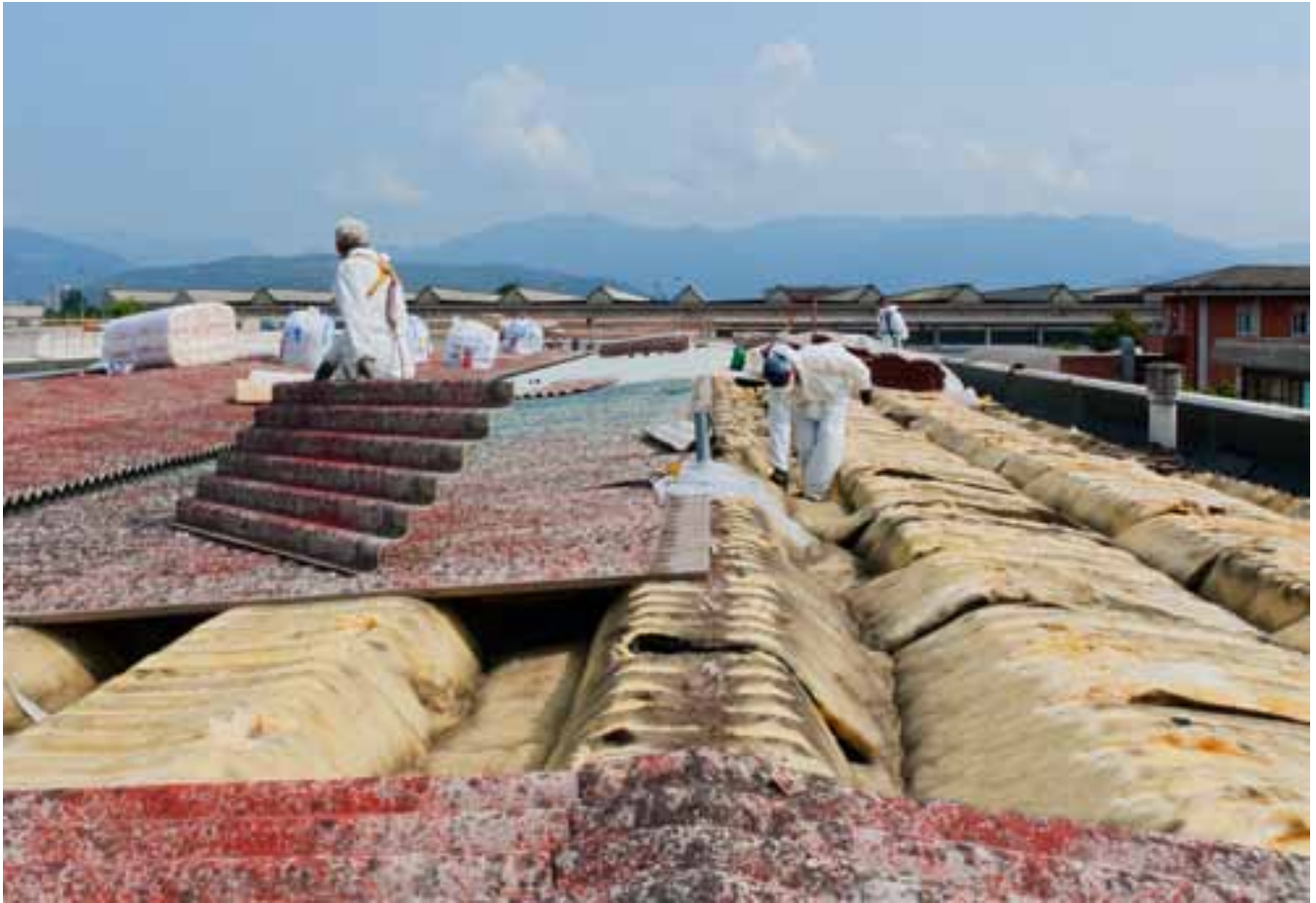
Gefahrstoffexposition: Asbestsanierung eines Daches.
