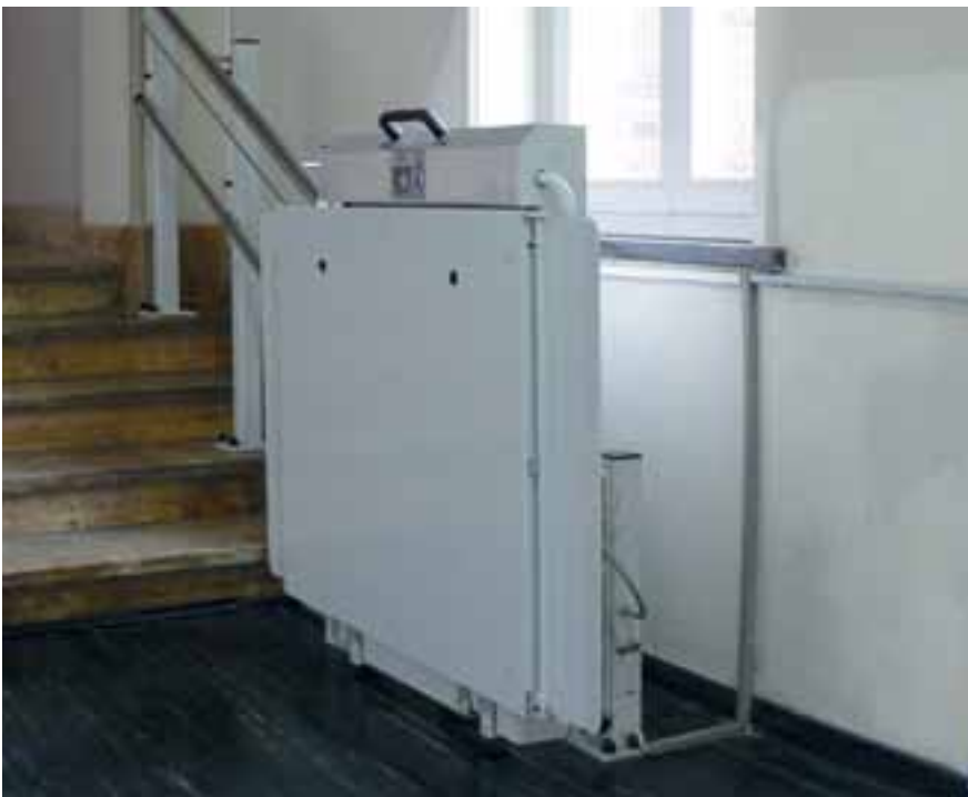
Nachrüstung eines Altbaus mit einem Plattformlift zur Überwindung einer Flur-treppe. Die Bedienung erfolgt über eine Schlüsselschaltung durch eine benannte Person. Die Barrierefreiheit ist damit stark eingeschränkt, da der Nutzer auf fremde Hilfe angewiesen ist.
