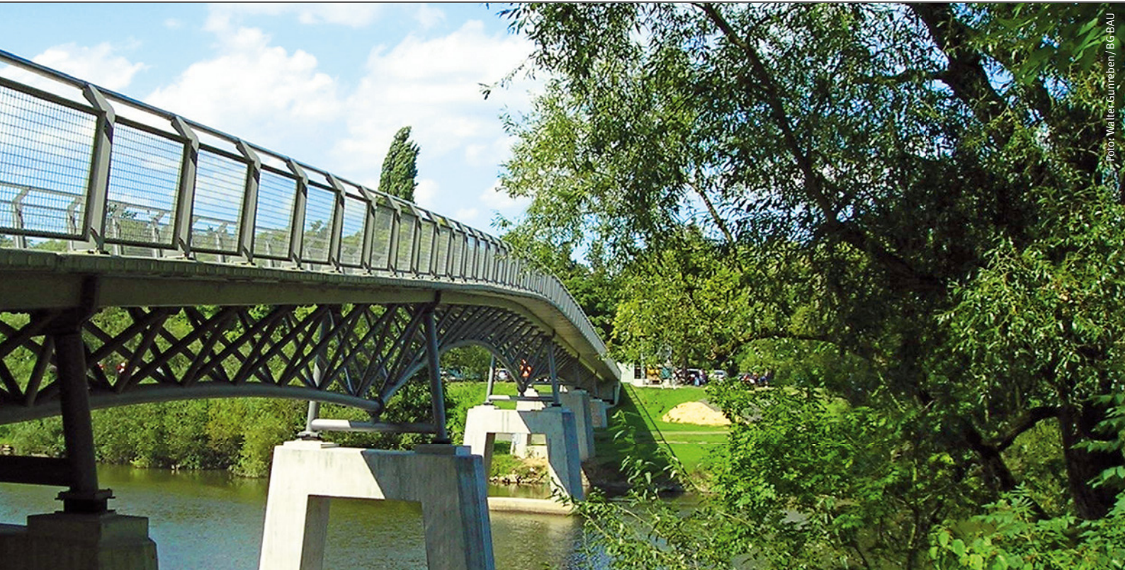
Gärtnerplatzbrücke in Kassel aus ultrahochfestem Beton
